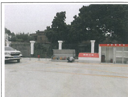
密闭卸油口与消防器材
