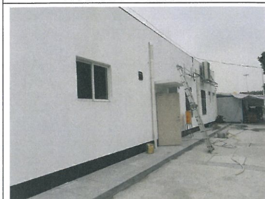
加油站配电间
