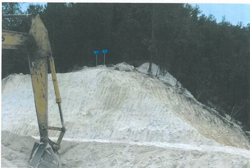
顶部剥离台阶正面
