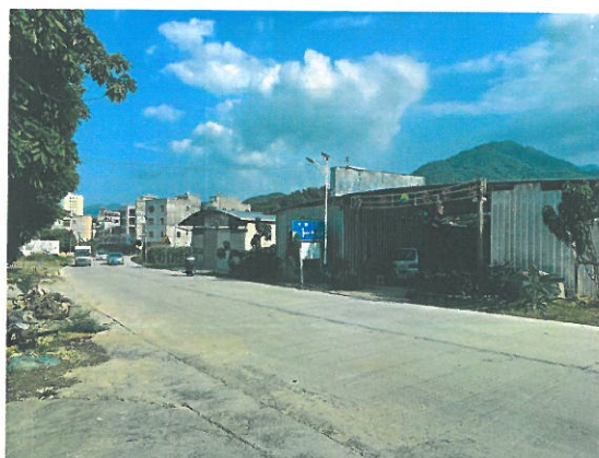
东南面建筑物
