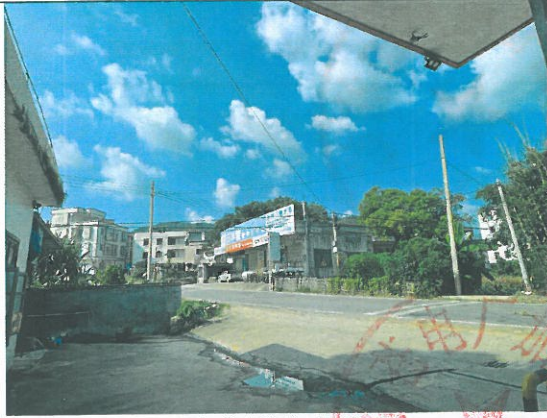
东北面电力线
