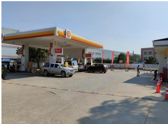
油站正面照片
