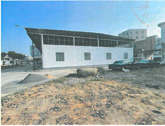
东北侧丙类仓库
