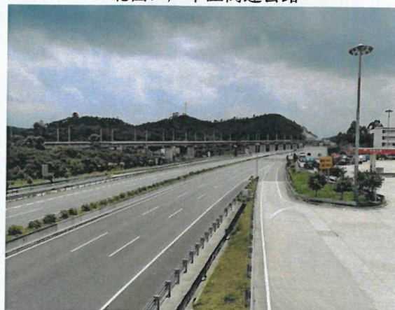
南面：小车充电桩充电区、停车场 2
