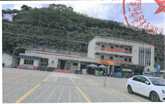
西面：人行天桥
