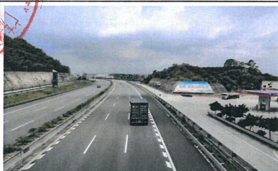
西北面：服务区水电房
