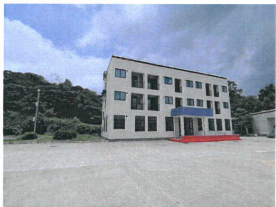
西北面：修车库
