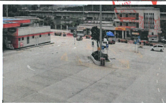
西北面：交警楼
