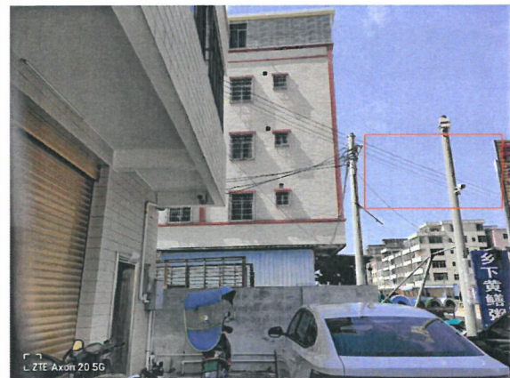
西北面的电力线
