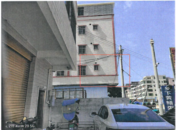
西北面的通讯线
