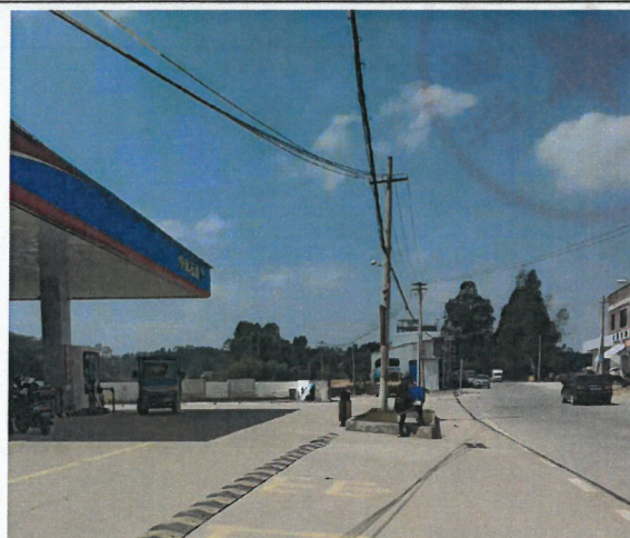
东北面通讯线以及北面电力线
