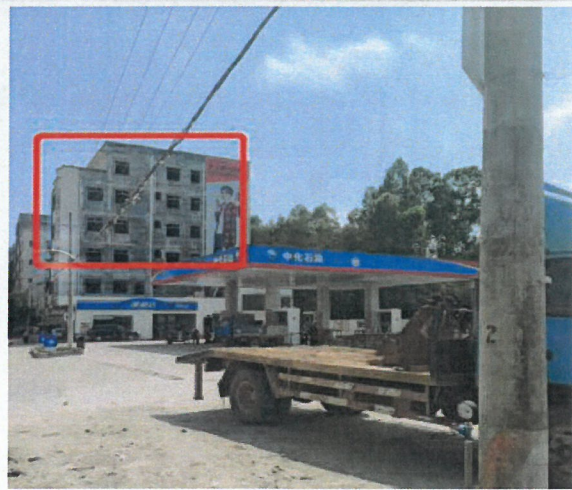
东南面建筑物
