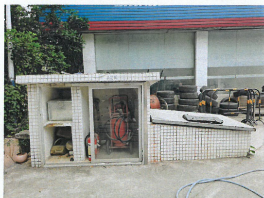
消防沙池以及消防器材柜
