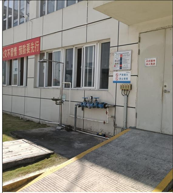
制冷机房人体静电导除装置和应急淋洗器照片
