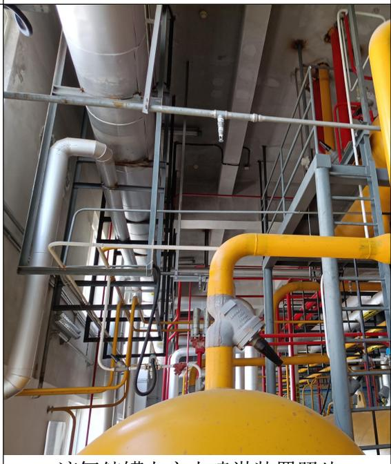
液氨储罐上方水喷淋装置照片
