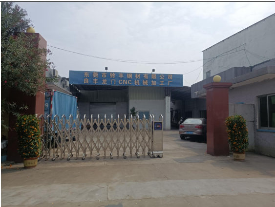
厂区外南面照片
