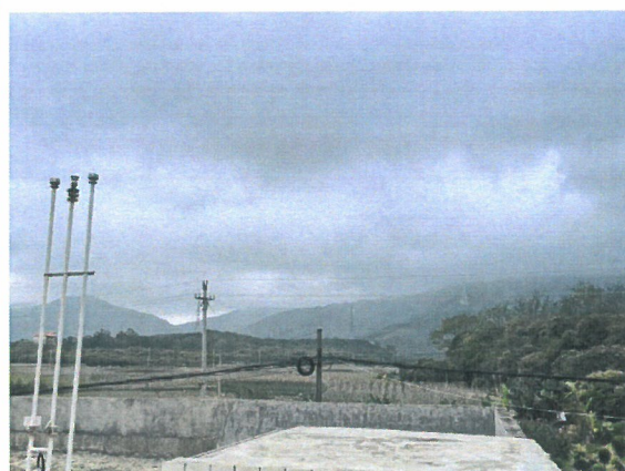
北面农田、架空电力线以及架空通讯线
