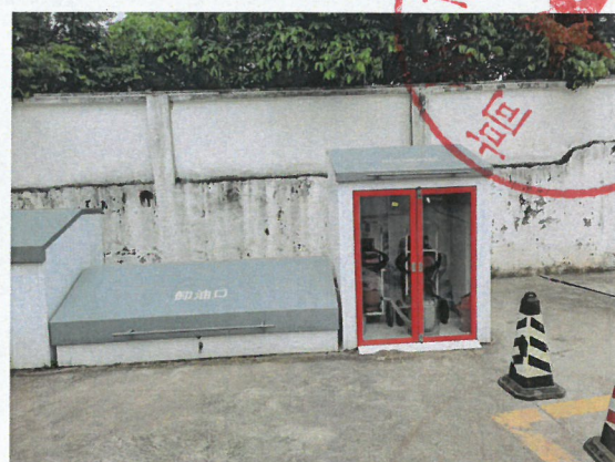
卸油口和消防间
