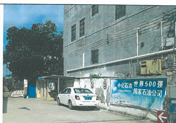
西北面电力线
