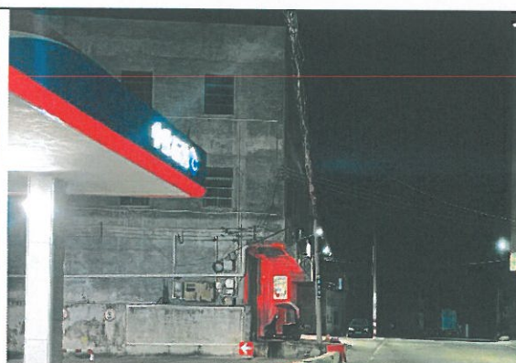
东北面通信线
