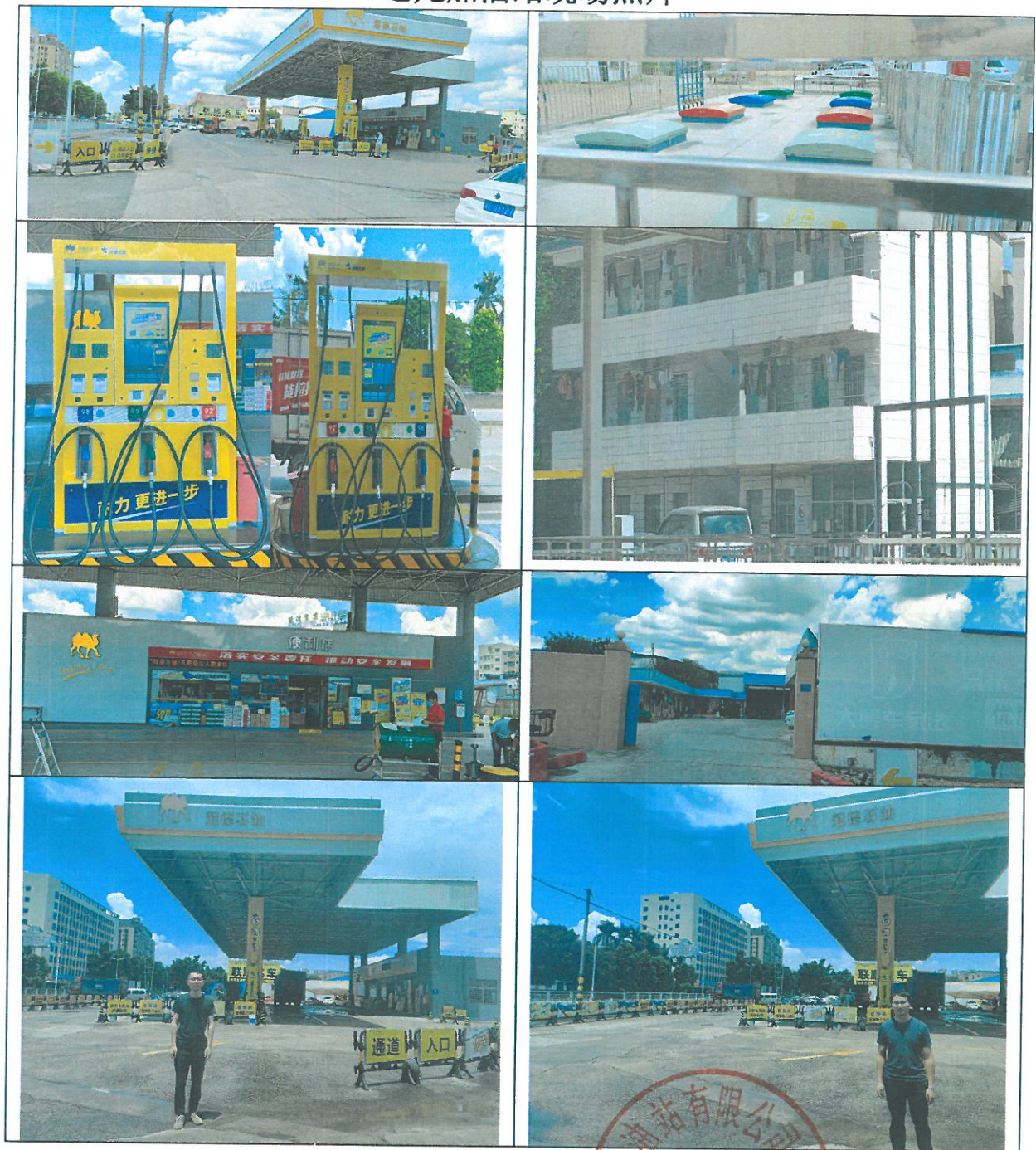
运龙加油站现场照片
